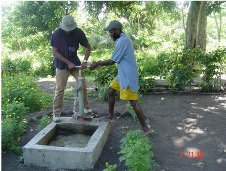
Photo2 Exemple d'un puit et d'une pompe à eau installée sur Paama
