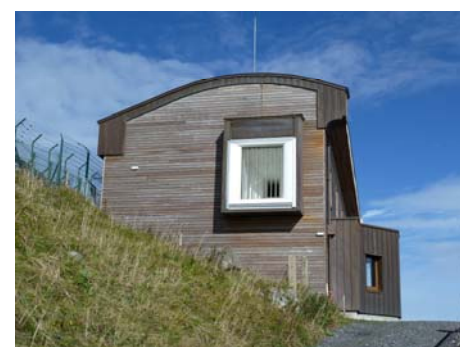
Entrée de la soufflerie à l'Observatoire.
